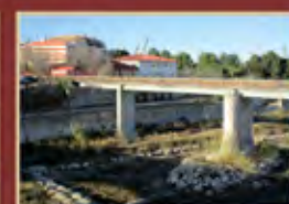
12 Via Verda La Safor. Gandia. Pont riu Serpis
