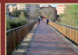
11 Via Verda La Safor. Gandia. Pont riu Serpis
